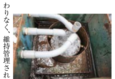
50分の1に区切られたマスが残る (写真の左下部分)
