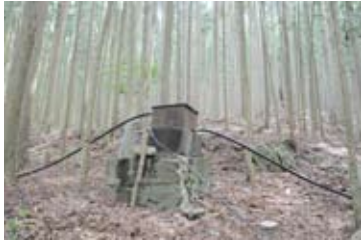
柏木地区の上垣内集落が利用する貯水タンクの「分水」
