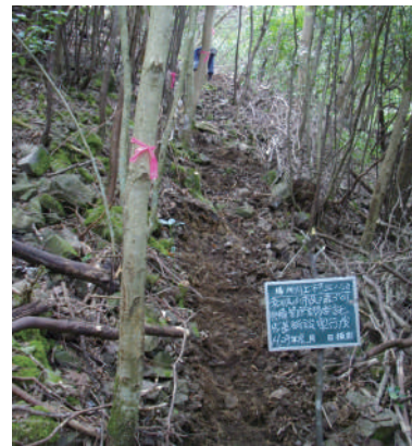
作業道の補修
