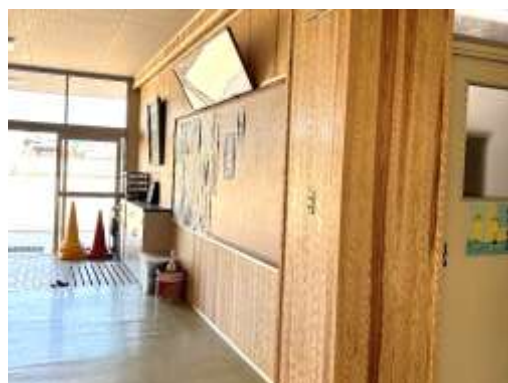
壁面の一部を木質化した小学校
