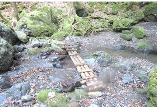
「水源地の森」内の木橋修理
