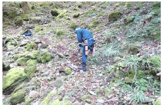
「水源地の森」内の散策道修繕
