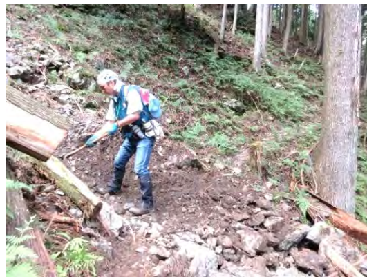
散策道の修繕
