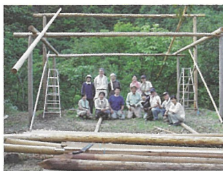
▲ 棟上げまで完成
