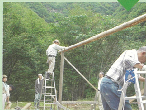
▲▼ 表桁を乗せ、桁と柱をかすがいで固定
