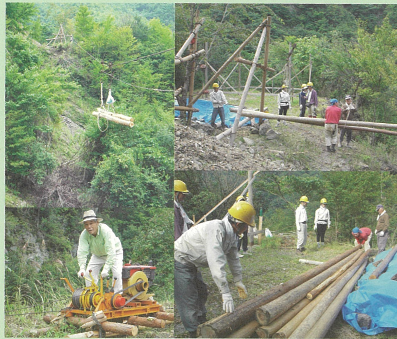
▲ 左上・右上：架線であげる 左下：辻谷館長 右下：架線であげた材を並べる
