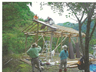
▲ トタン板を止めている様子
