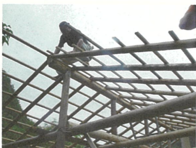
▲ 屋根の骨組みの様子
