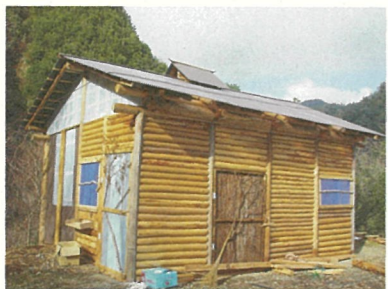
▲ 煙抜き出来上がり
