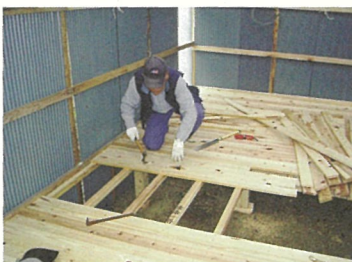
▲ 床板(とこい)を根太(ねた)に打ち付けているところ
