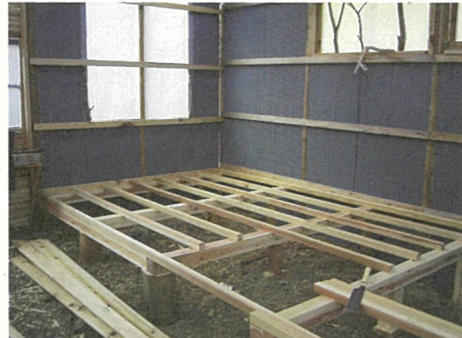
▲ 大引(おおいび)と根太(ねた)(上の細い角材(こま)が根太、それを支(た)えている太い角材(こま)が大引)
