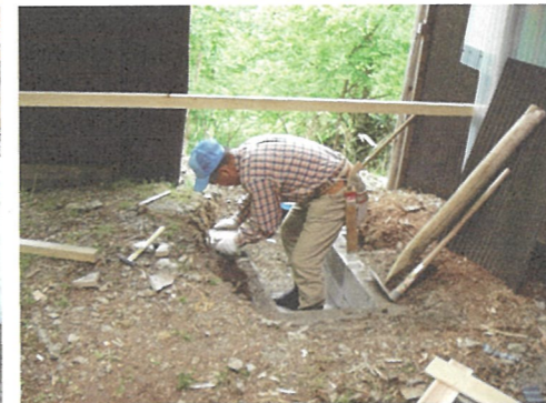
▲ 図2. 地面を掘って焚き口を作っています
