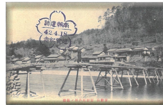
▲ ① 仮設の橋
