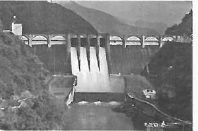
大滝ダムクレスト4門の試験湛水
