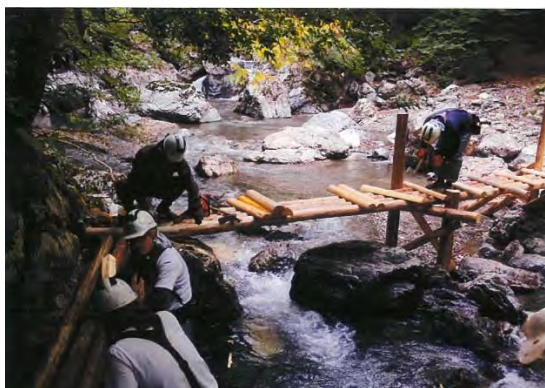
「水源地の森交流施設（休憩小屋・管理棟）」の定期的な見回り・点検・清掃・修繕を実施。例年大雨により流出する休憩小屋前の木橋の復旧、また休憩小屋に掛かった倒木を発見し役場へ通報、管理棟に付帯するバイオトイレの電気回路の修理などを実施。
